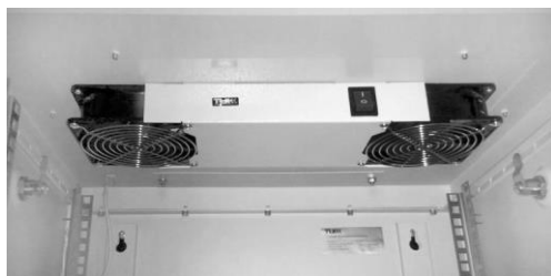
Установленный вентиляторный блок в шкафу
