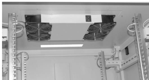
Установленный вентиляторный блок в шкафу
